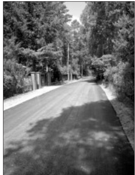
Nowa nakładka asfaltowa na ul. Szmaragdowych Żuków
