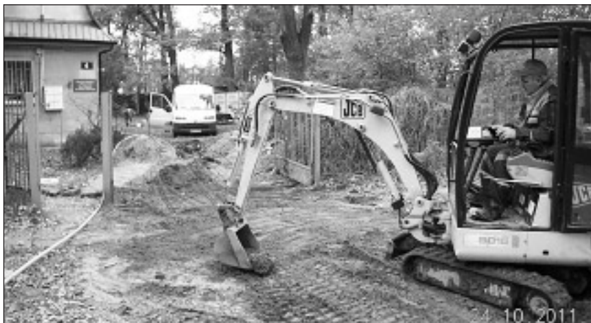
Dzięki środkom z Centrum Kultury budynek Biblioteki i Klubu Kultury przy ul. Wiekowej Sosny 4 został podłączony do zbiorczej sieci wodociągowej
