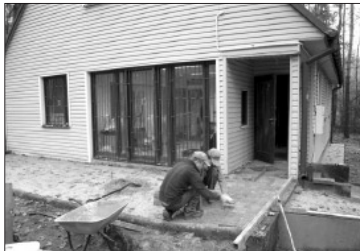
Układanie nowej kostki na tarasie
